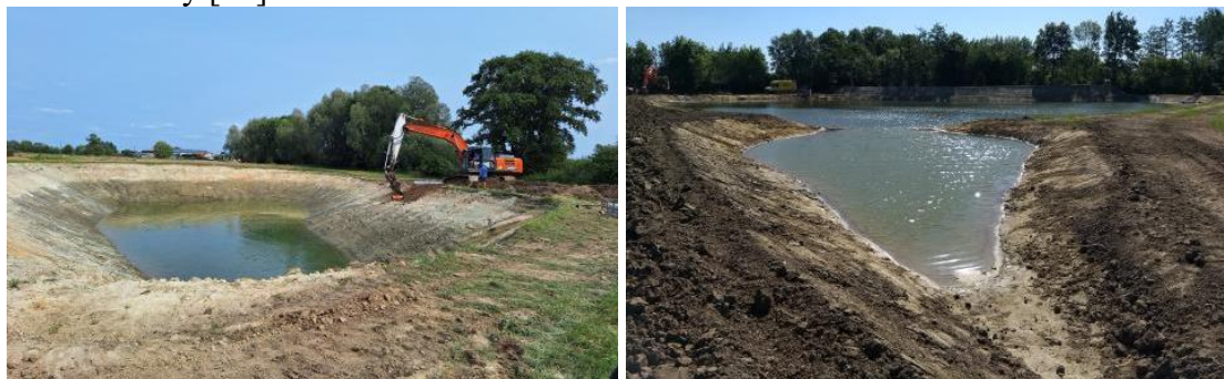
Rysunek 59. Water Buffers buforują wodę podczas deszczy i przechowują ją do wykorzystania podczas suszy [24]
