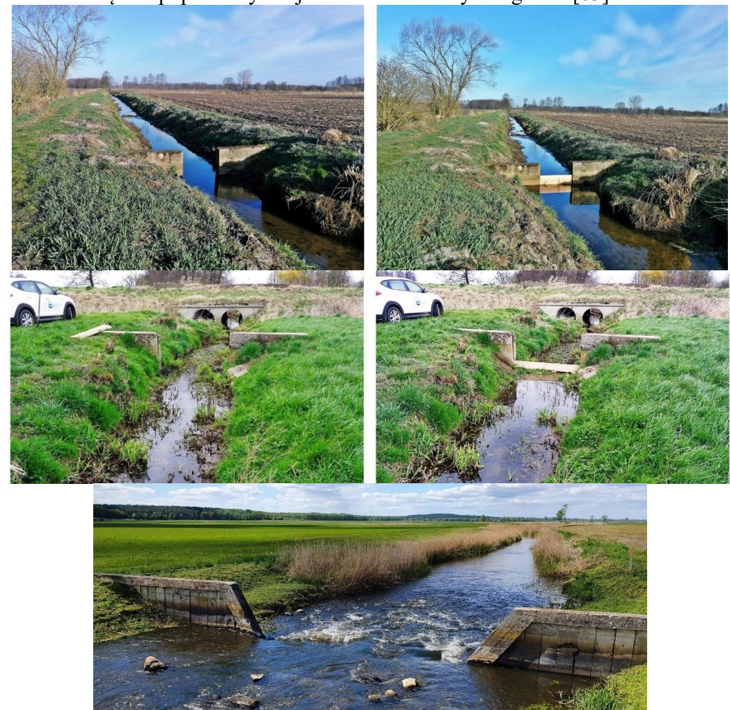
Rysunek 58. Przykład retencji korytowej [63]
